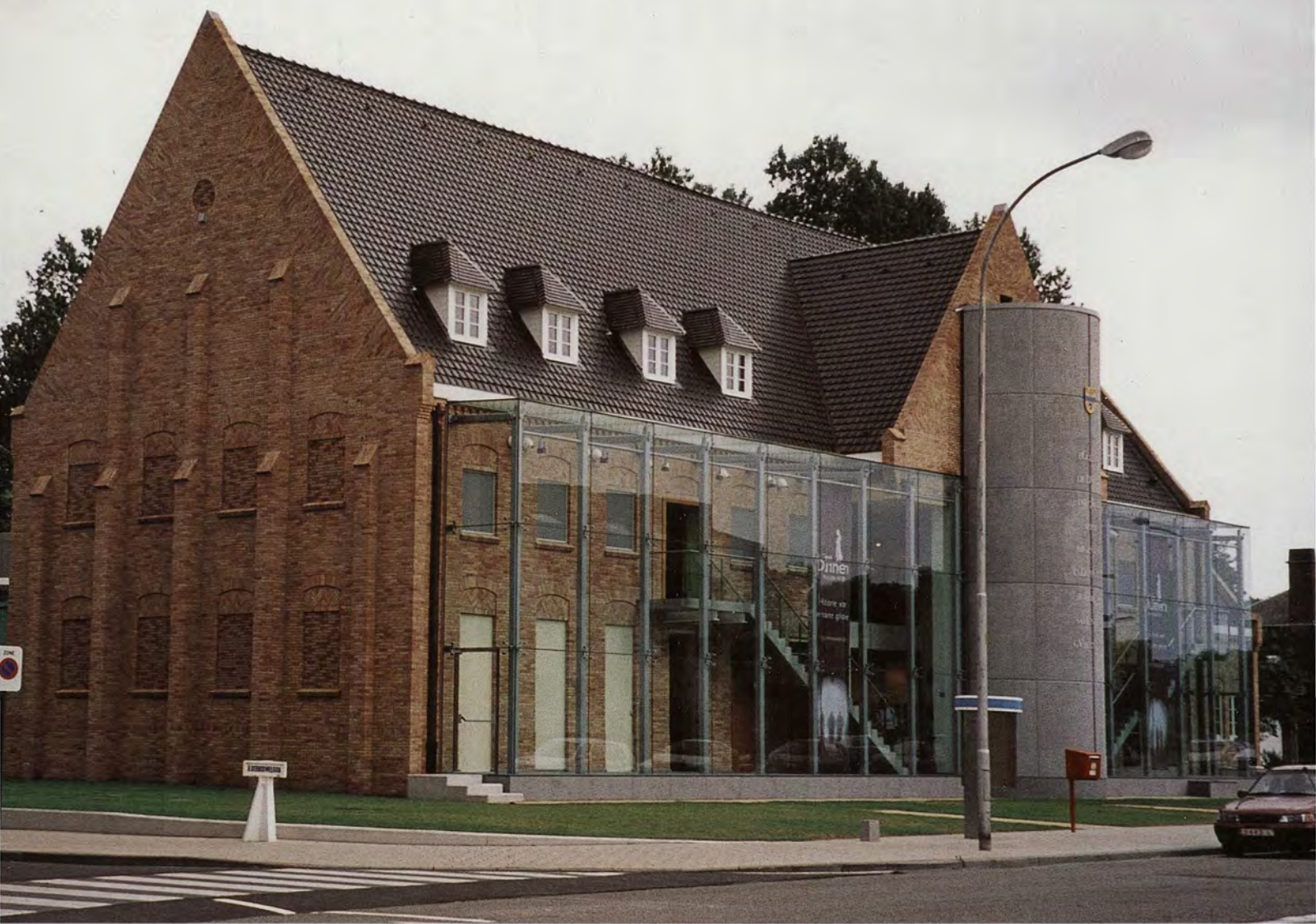
Vooraanzicht Abdijmuseum. Om het oude museum- gebouw aantrekkelijker te maken, werd er een glazen gevel voorgezet.
